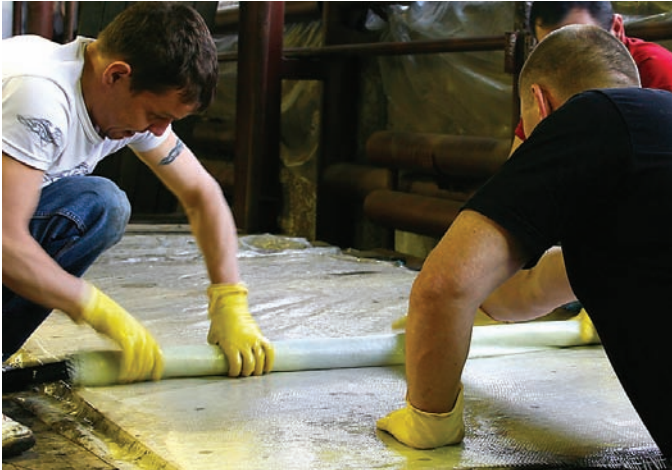
Укладка стеклоткани на поверхности
