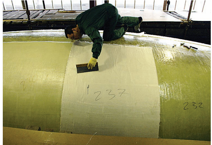
Стеклоткань разравнивается при помощи шпателя и валика
