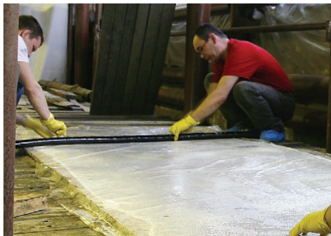
Пропитанная стеклоткань накручивается на резиновый шланг
