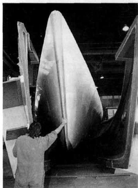
**После соединения по ДП двух секций корпуса снимаются матрицы**
