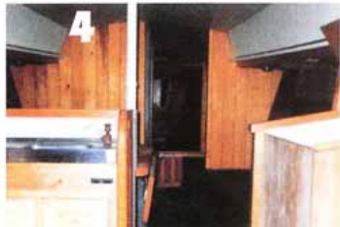
4 Навешиваются двери. Производится укладка кабелей и трубопроводов. Все окрашивается или лакируется
