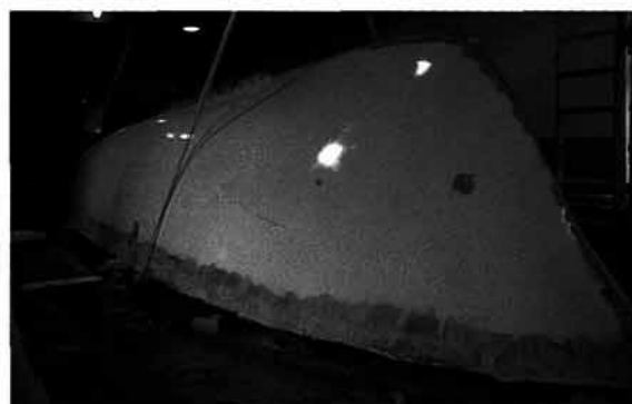
Нанесение первого слоя грунта Epifanes
