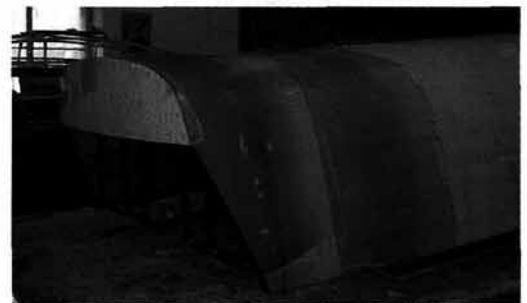
Подготовка корпуса к грунтовке
