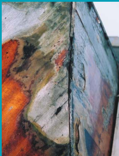
Рис. 6. Поврежденный стык транца и борта деревянной яхты. Такое повреждение требует уже капитального ремонта
