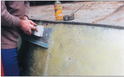
Снятие старого эпоксидного покрытия закругленным шпателем с помощью смывки СП-6. Защитный лакирующий слой дюралюминия при такой технологии сохраняется. Корпус 1968 года постройки. Вдоль скул по бортам — пятна коррозии — следствие накладок из нержавеющей с плохой адгезией к лакокрасочным материалам
