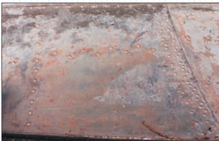
Тот же корпус после снятия лакокрасочного покрытия с помощью смывки. Хорошо видны пятна коррозии черного цвета и места глубокой коррозии вдоль киля. Пятна вдоль заклепок на горизонтальном клепаном шве — поврежденный плакирующий слой.
