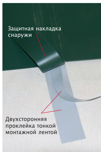
Так устроены стыковые швы баллонов
