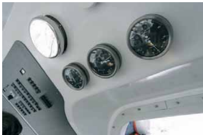
Распределительный щит и вспомогательные приборы вынесены на заднюю стенку рубки
