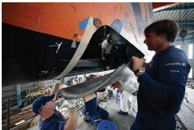
Ремонт трещины (фото справа) в корпусе яхты «Ericsson 3»
