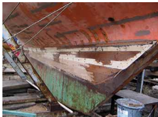
Рис. 11. Примыкающая к килю часть днища после ремонта
