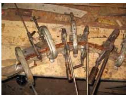
Рис. 7. Выклеивание заготовок новых окончатий шпангоутов
