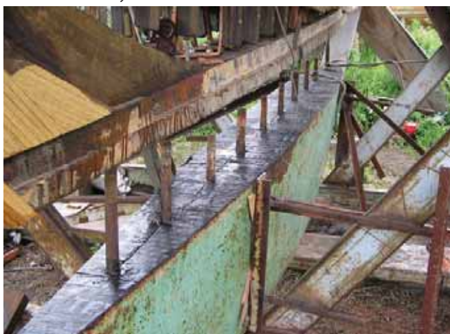
Рис. 10. Подготовка фальшкиля к установке на место
