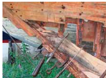
Рис. 4. Ремонт нижней части ахтерштевня
