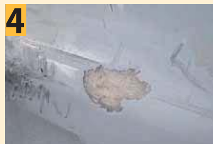
После механической обработки необходимо все место ремонта протереть ацетоном
