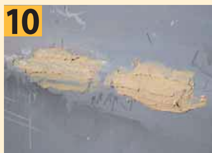
Наносим первый слой универсальной шпатлевки
