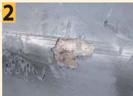
Убираем все отложения, отслаивающееся декоративное покрытие и обрабатываем данное место обезжиривающим веществом (в нашем случае – ацетоном)
