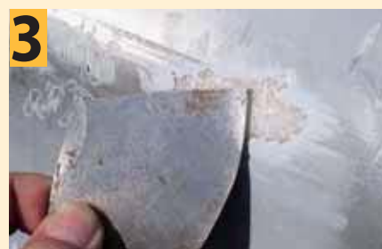
Обработка импровизированной «циклей»: зачищаем всю поверхность, захватывая участки декоративного слоя, при этом стараемся не повредить волокна стеклоткани
