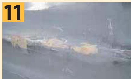
Обрабатываем поврежденное место шкуркой, выводя нужную конфигурацию поверхности
