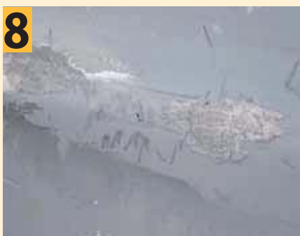
Предварительная обработка наждачной шкуркой зернистостью от 40 до 60
