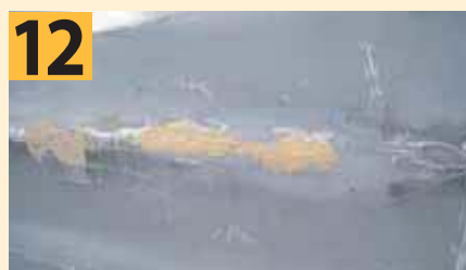
Наносим второй слой универсальной шпатлевки
