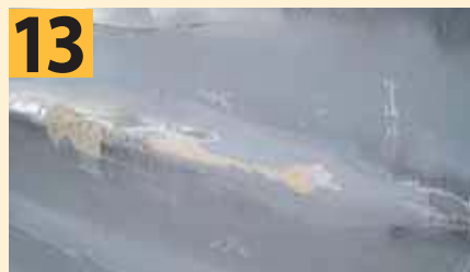
Доводим наждачной шкуркой ремонтируемый участок до «кондиции»
