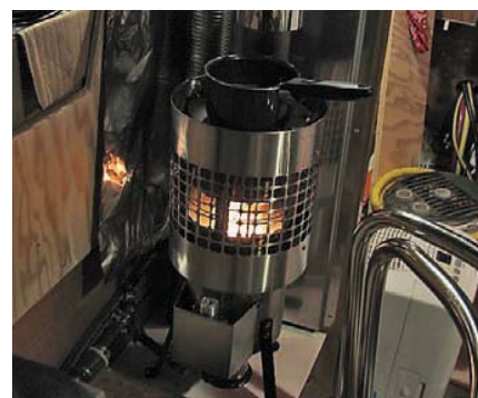
Напольная дизельная печка «Sigmar 180». На ней можно подогреть кофейник или разогреть еду. В конструкции печки предусмотрена возможность подсоединения 76-миллиметрового воздуховода системы сбалансированной тяги. Есть смотровое окошко. Теплопроизводительность, мин./макс. – 1.9–4.7 кВт. Расход топлива, мин./макс. – 5/10 л/сут. Диаметр корпуса – 254 мм, высота – 70 см. Диаметр дымохода – 76 мм. Фирма «Sig Marine, Ltd.», Канада.
