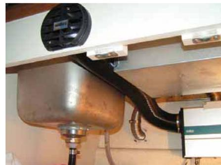
**Скрытый монтаж отопителя «Wallas 1300» в мебельной секции камбузной мойки.** Выход горячего воздуха в салон – через круглую жалюзийную решетку в верхней части секции. Решетку в данном случае пришлось немного подрезать. Рециркуляционный воздух самотеком поступает на отопитель через такую же решетку в нижней части секции.
