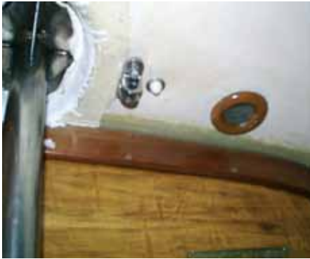
Рис. 8. Верхняя точка крепления струны
