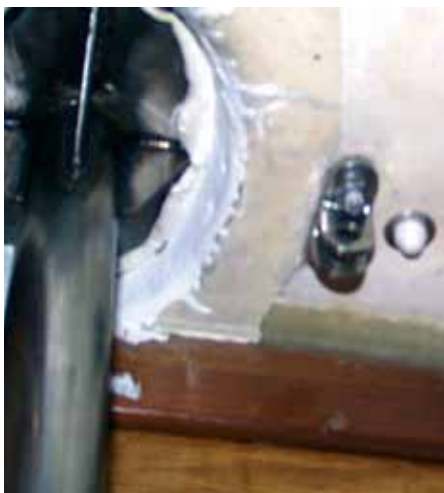
Рис. 3. Пиллерс с фланцем из каюты. Видны косынки.
