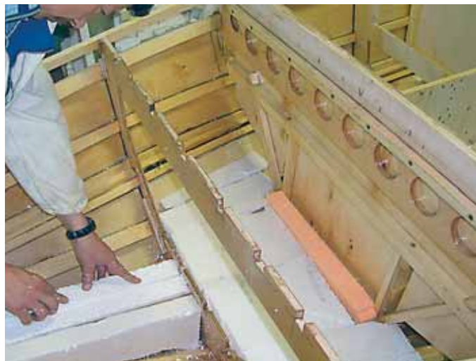
Укладка блоков пенопласта и установка пайола.
