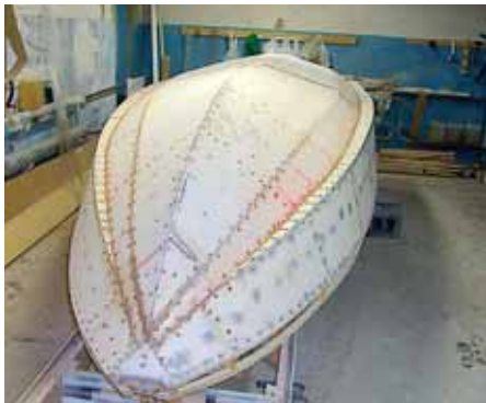
Монтаж наружной обшивки закончен. Заделываются головки шурупов.
