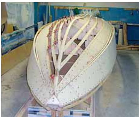
Идет установки обшивки. Поставлены бортовые пояся и верхние пояся днища.
