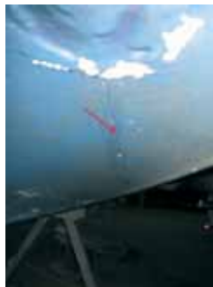
Рис. 7. Трещина в районе mortar гребного вала катера «Sunseeker 44 Camarque» после поверхностного ремонта
