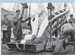
Монтаж деревянной носовой фигуры (длина – 3,8 м)
