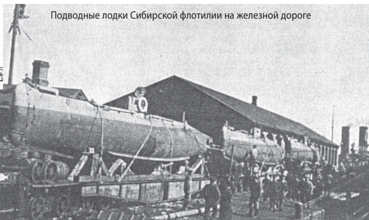
Транспортер для перевозки «Дельфина» по железной дороге. Спроектирован И. Г. Бубновым, построен на Путиловском заводе.
