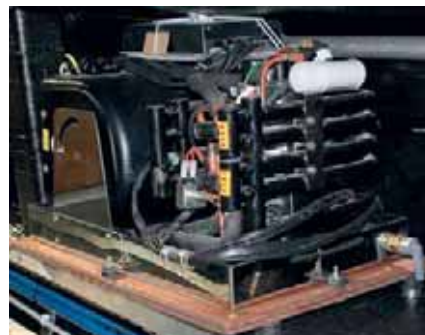
Двухкаскадная амортизация моноблочного кондиционера «Climma», примененная при монтаже системы на яхте
