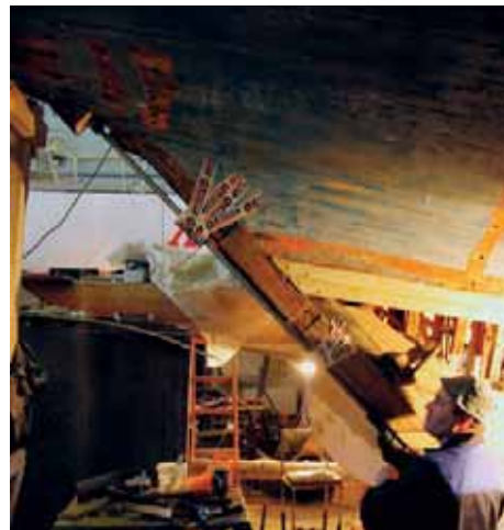
Сверлим отверстие в контртимберс под баллер
