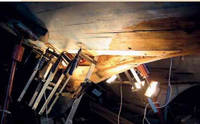
Вклейка первого пояса обшивки
