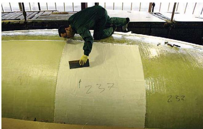
Стеклоткань разравнивается при помощи шпателя и валика
