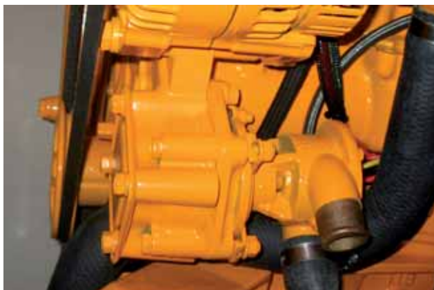
Рис. 3. Установка насоса забортной воды на дизеле
